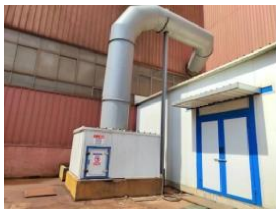
喷砂房粉尘收集排放系统改造
